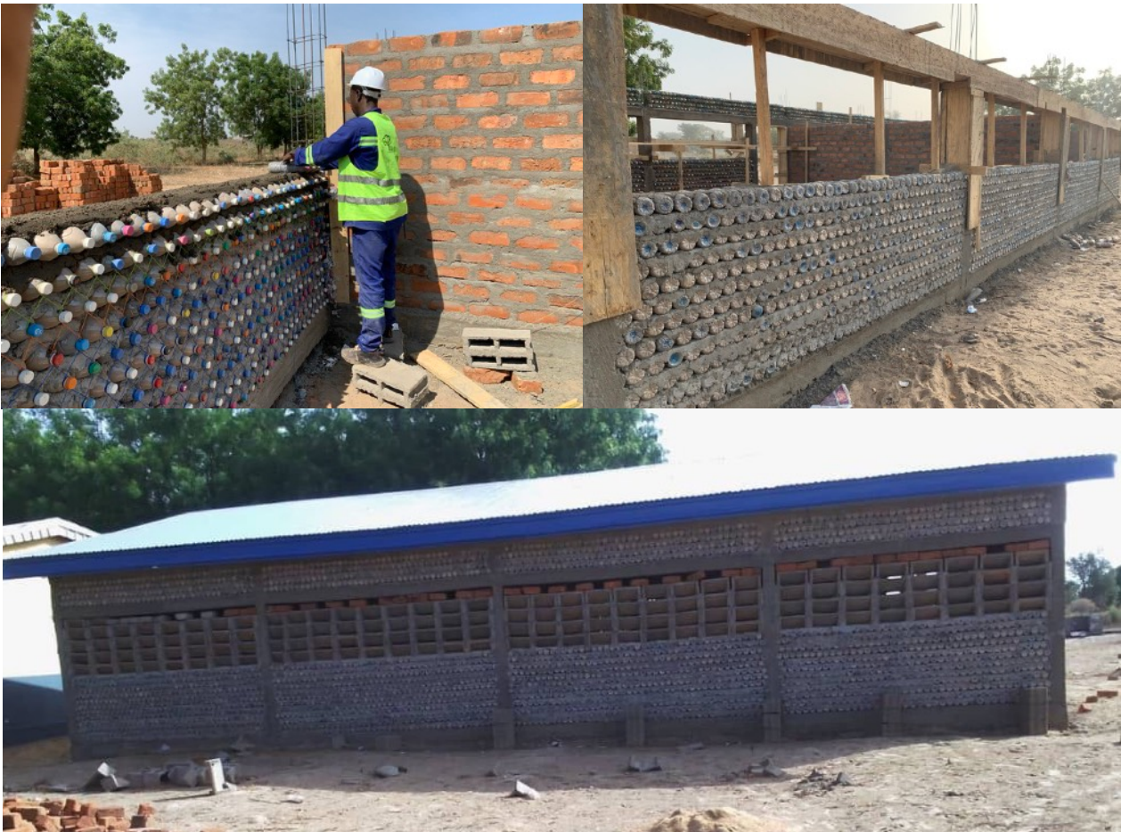
Abbildung 12: Schulbau mit Ecobricks in Kamerun (PET Flaschen dienen als Baumaterial) aus Flaschen, die 2023 von Sana Mare aus Flüssen gesammelt wurden.
