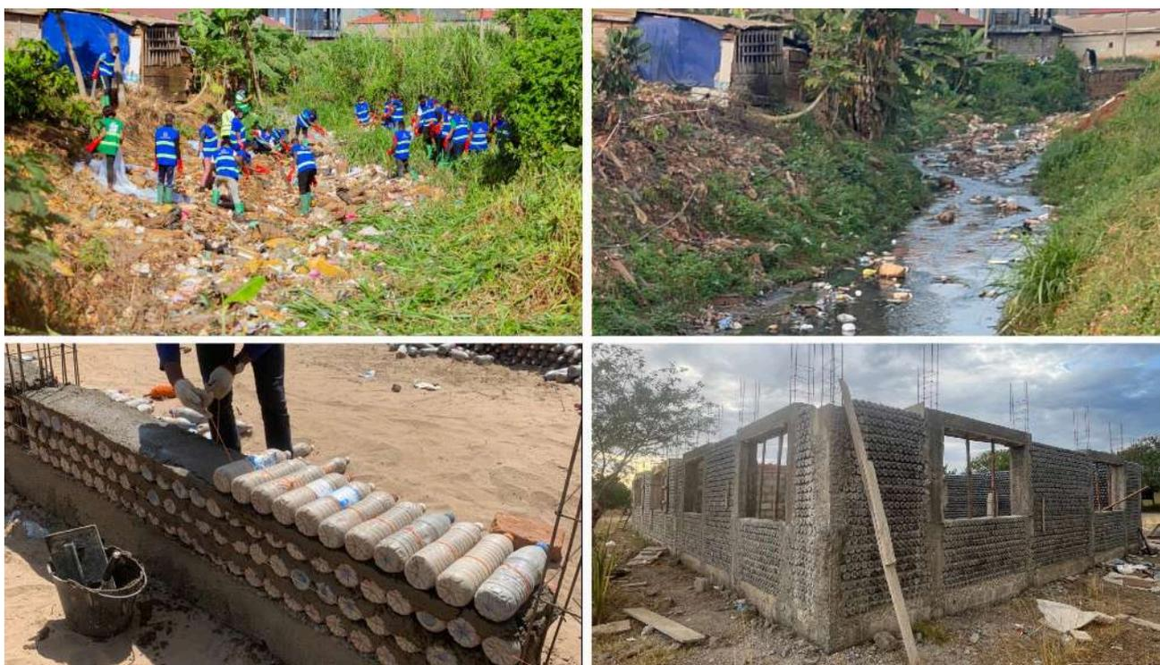
Abbildung 3: Oben links: Der verschmutzte Fluss in Yaoundé vor Beginn des Cleanups am 19.04.2024. Oben rechts: der gleiche Ort wie oben links nach dem Cleanup . Unten links: Aufbau einer Mauer des neuen Schulgebäudes mit Flaschen, die aus dem Fluss (Bild oben links) gesammelt wurden. Unten rechts: Die beinahe vollständig fertiggestellten Mauern des neuen Schulgebäudes aus Ecobricks.
